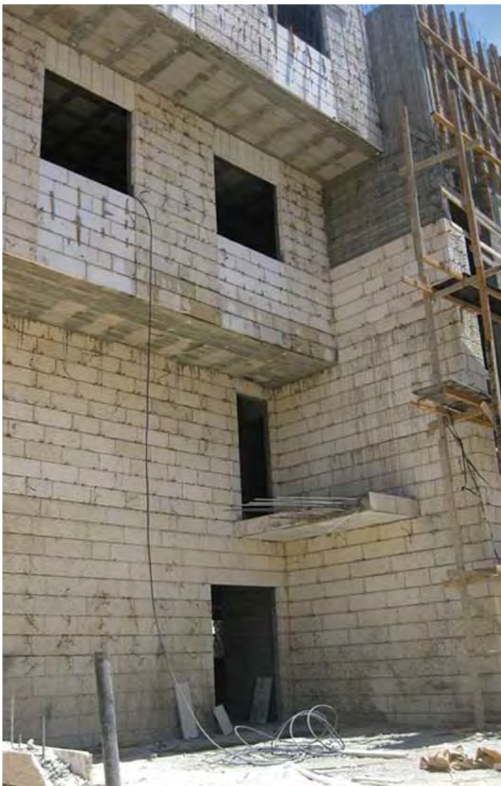
Lavori strutturali a Beit Safafa.
