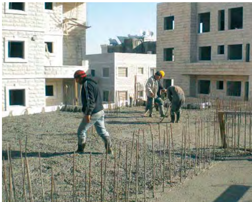
Una casa in costruzione a Beit Safafa.
